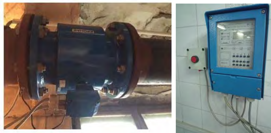
Слика 2.2: Лево: Цевни ЕМ сензор који се налази у подруму лабораторије Института за хидротехнику и водно – еколошко инжењерство Грађевинског факултета у Београду; Десно: Претварач, логер и дисплеј за Цевни ЕМ сензор
