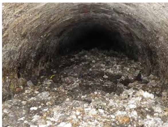
Slika 2.12 Kanalizacioni kolektor blokiran očvršćenim masnim naslagama u Londonu, Ujedinjeno Kraljevstvo (preuzeto sa www.neogaf.com )
