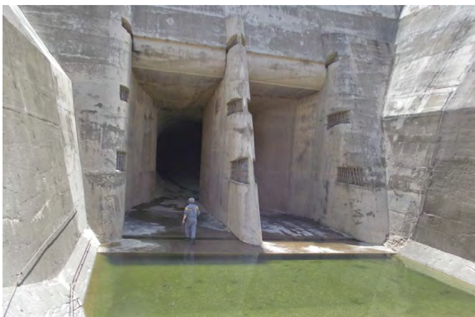
Slika 6.5 Ulaz u derivacioni tunel Fatničko polje – Bilećka akumulacija
