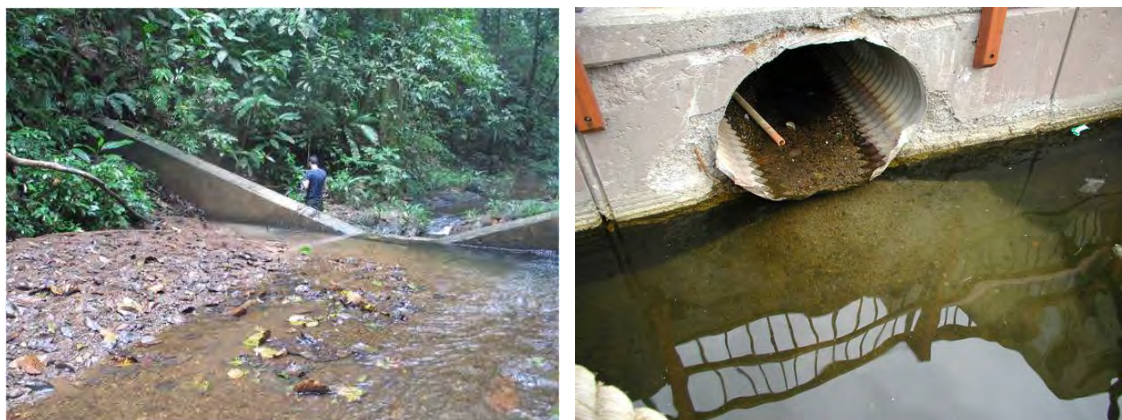
Slika 2.11 Levo) Sedimentacija prilazne deonice trougaoanog preliva (Ogden i saradnici, 2017), Desno) Sedimentacija na dnu kišnog kolektora (preuzeto sa rpitt.eng.ua.edu )
