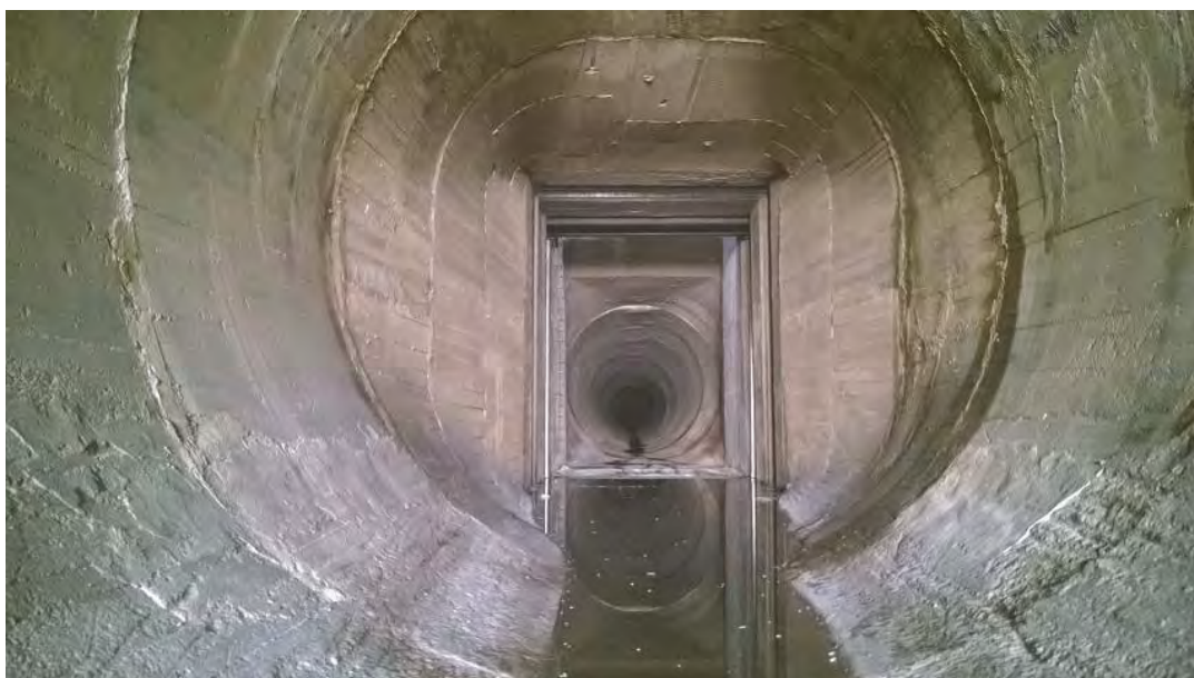
Slika 6.6 Prelazak sa kružnog na pravougaoni presek na mestu tablastih zatvarača neposredno nizvodno od ulazne građevine
