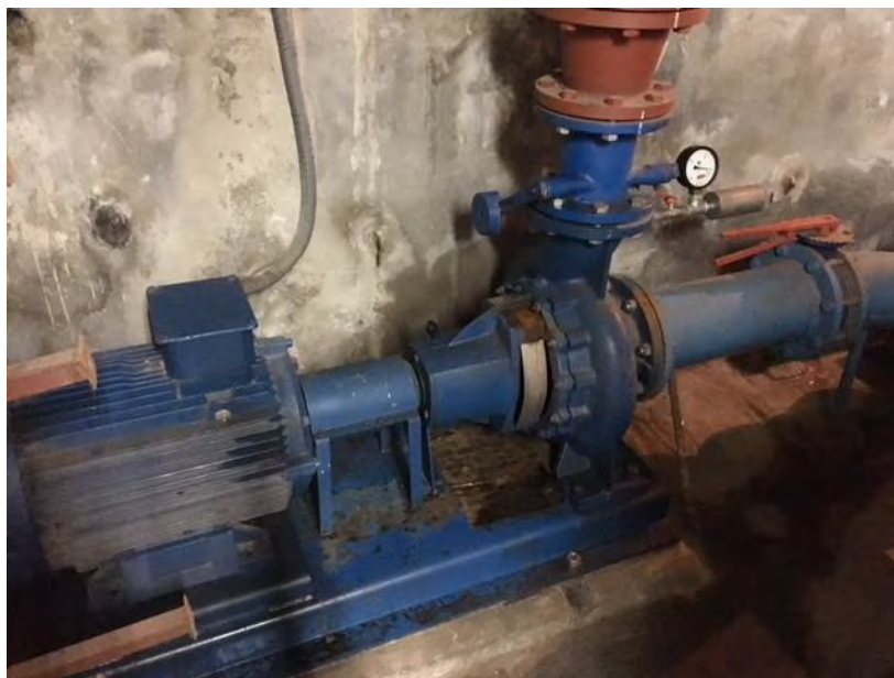
Slika 3.11 Ebara pumpa 150-315, u podrumu hidrauličke laboratorije, Građevinskog fakulteta, Univerziteta u Beogradu.
