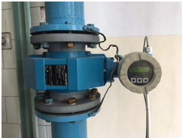
Slika 2.1 Endress – Hauser cevni EM senzor protoka na instalaciji u hidrauličkoj laboratoriji Građevinskog fakulteta, Univerziteta u Beogradu.
