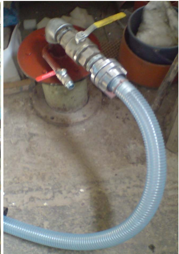
Слика 14: Хидрант са затварачем
