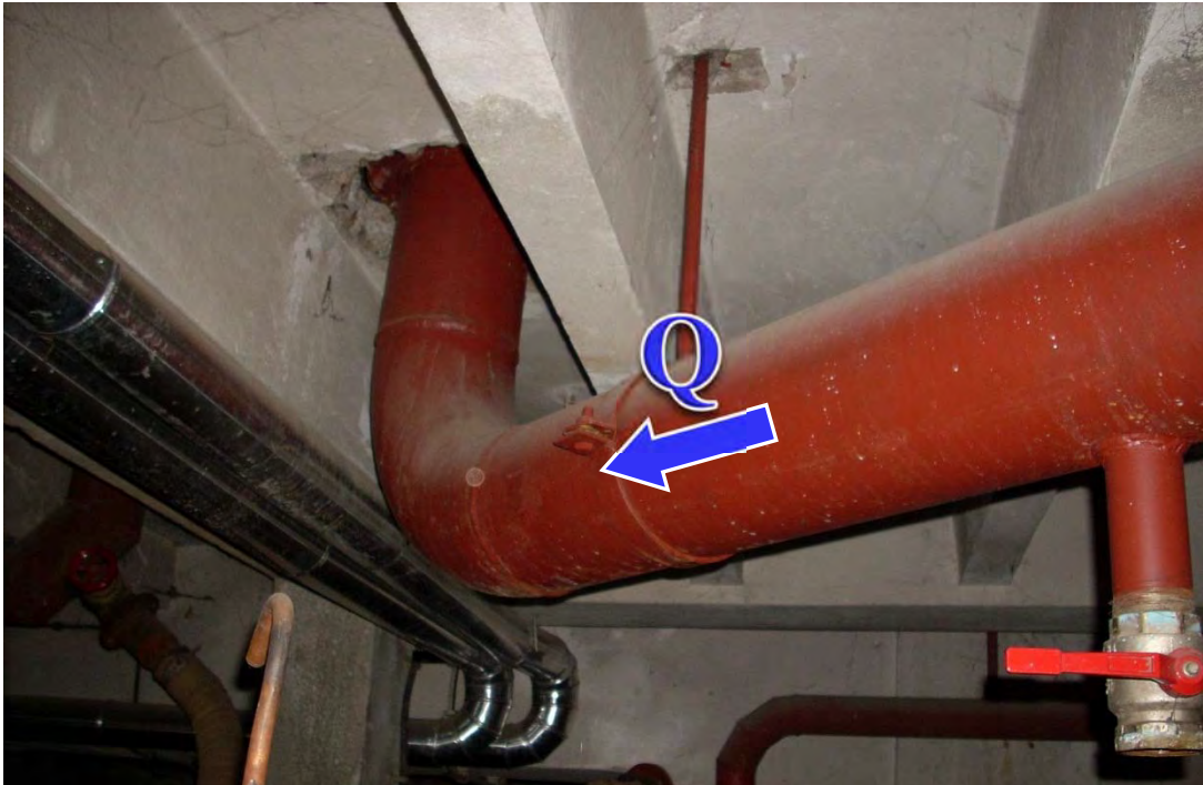
Слика 14. Узрок деформације струјне слике, прво колено
