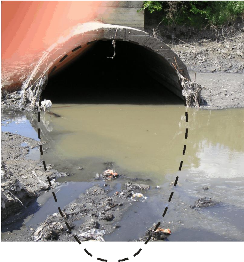
Slika 10: Realni radni uslovi sonde za merenje protoka u kanalizaciji: ispust visine 4 m potpuno potopljen visokom kotom Dunava sa brzinama u toku dana manjim od par centimetara u sekundi i velikim nanosom preko sonde
