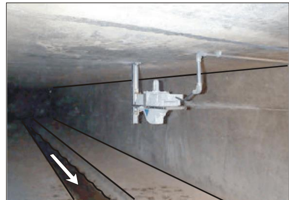
Slika 8. Primer montaže radarskog senzora u velikom kanalizacionom kolektoru
