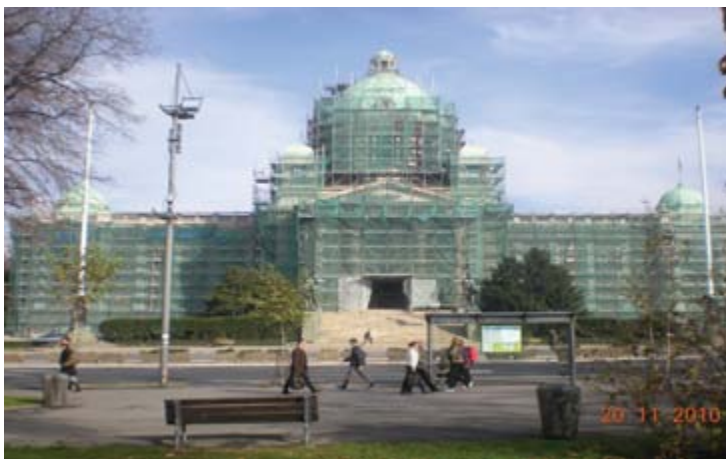
Санација конструкције Дома Народне скупштине у Београду
