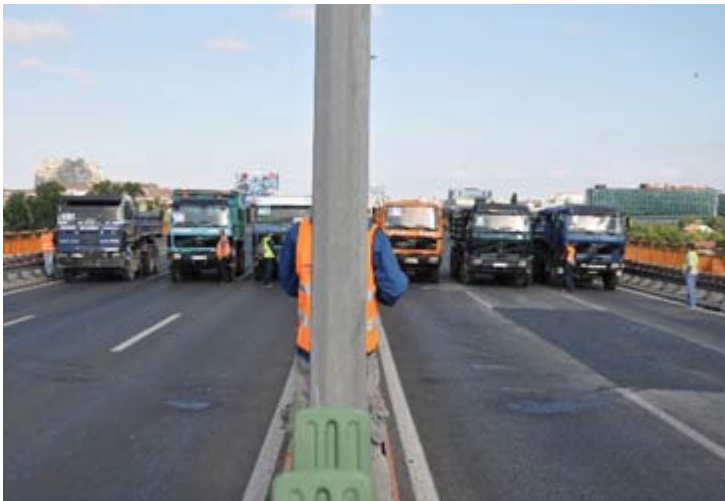
Испитивање моста Газела у Београду пробним оптерећењем
