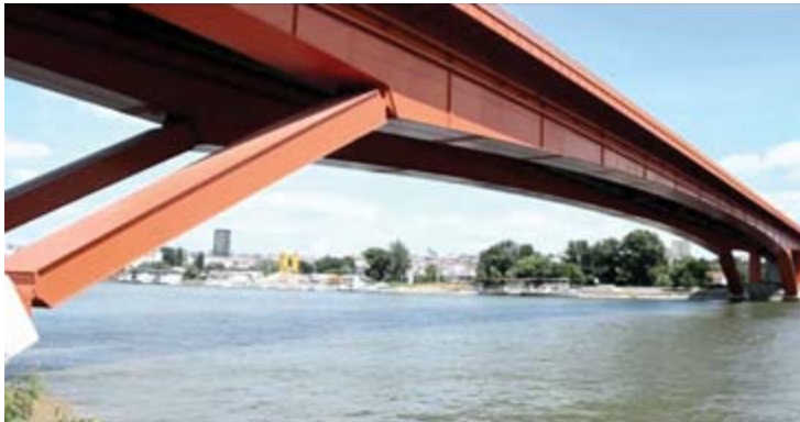
Мост Газела преко Саве у Београду
