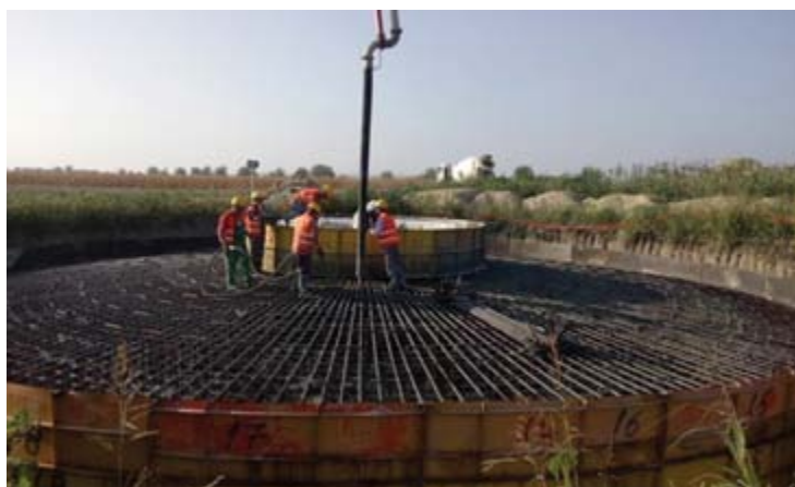
Завршна фаза армирања темеља ветротурбине у ветропарку Кошава
