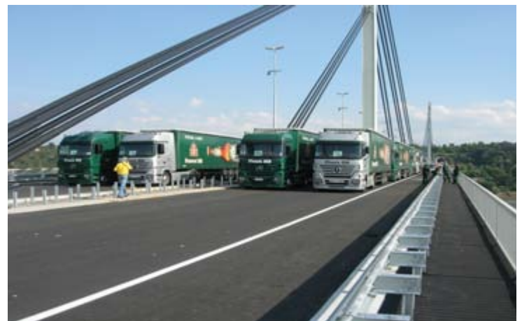
Испитивање Моста слободе преко Дунава у Новом Саду
