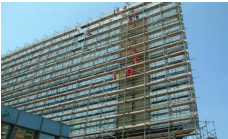
Реконструкција стаклене фасаде хотела Hyatt Regency у Београду
