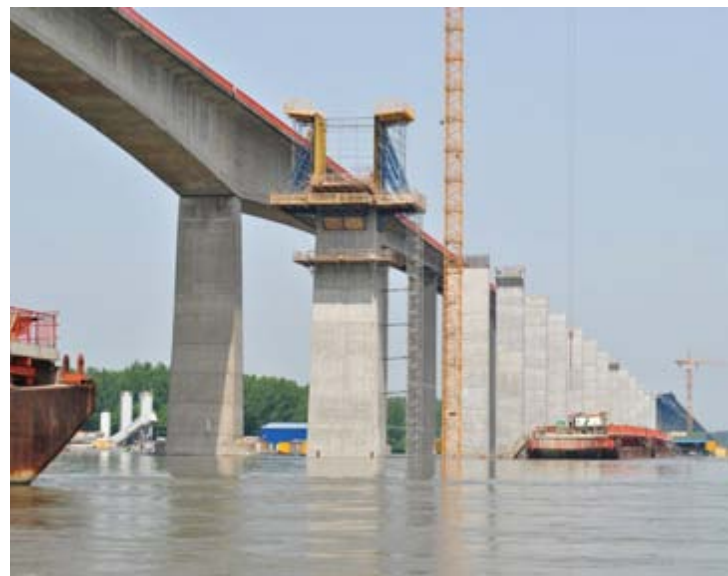
Нови друмски мост преко Дунава код Бешке у току изградње
