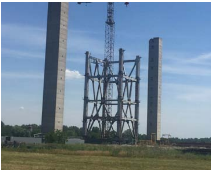
ТЕ Колубара Б у изградњи – постојећа конструкција гериста и лифтовских торњева
