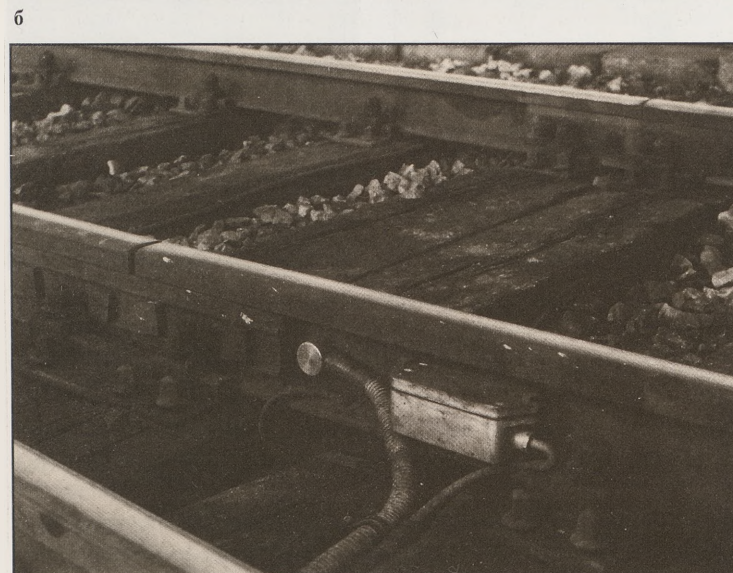
Слика 8 – а – Колосечна ситуација на Ранжирној станици у Београду са електронским системом за укључивање грејача скрејница; б – Изглед развијеног грејварача за мерење температуре вратица шине
