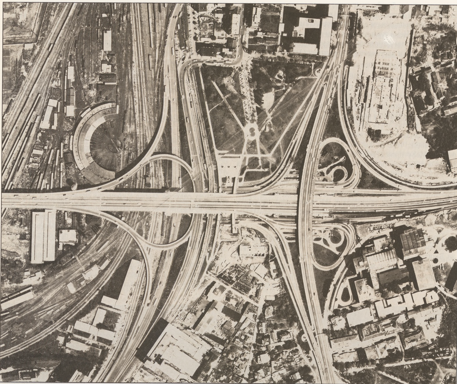
Слика 10 – Денивелсана раскрсница „Мостар“ на аутопутоу кроз Београд
