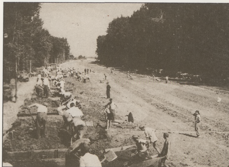
Слика 5 – Изградња пута Београд–Загреб кроз Војводину
