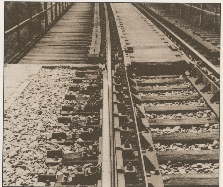
Слика 17 – Горњи строј железнице на мостовској конструкцији
