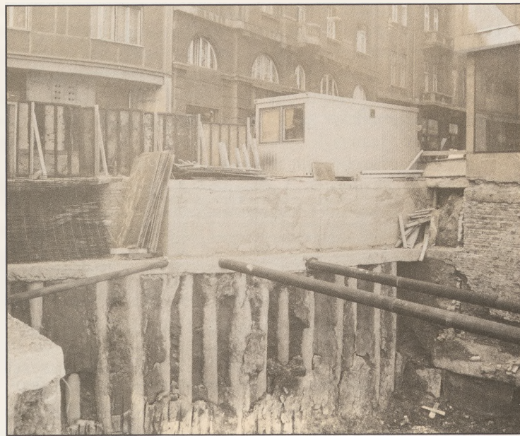
Слика 23 – Заштитна темељне јаме завесом шпирова – објекти „Аркаде“ у Београду
