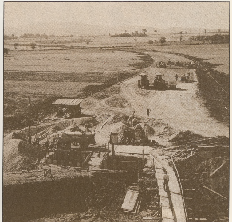
Слика 9 – Изградња пута Београд–Ђевђелија
