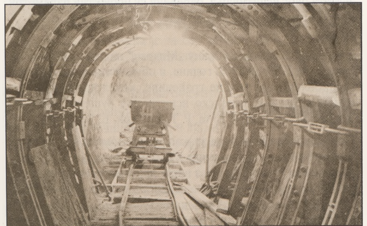
Слика 3 – Изградња главног водоводног тунела „Безанија“ у Београду – I етапа
