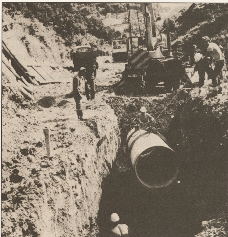
Слика 15 – Изградња главног фекалног колектора у Ужцу
