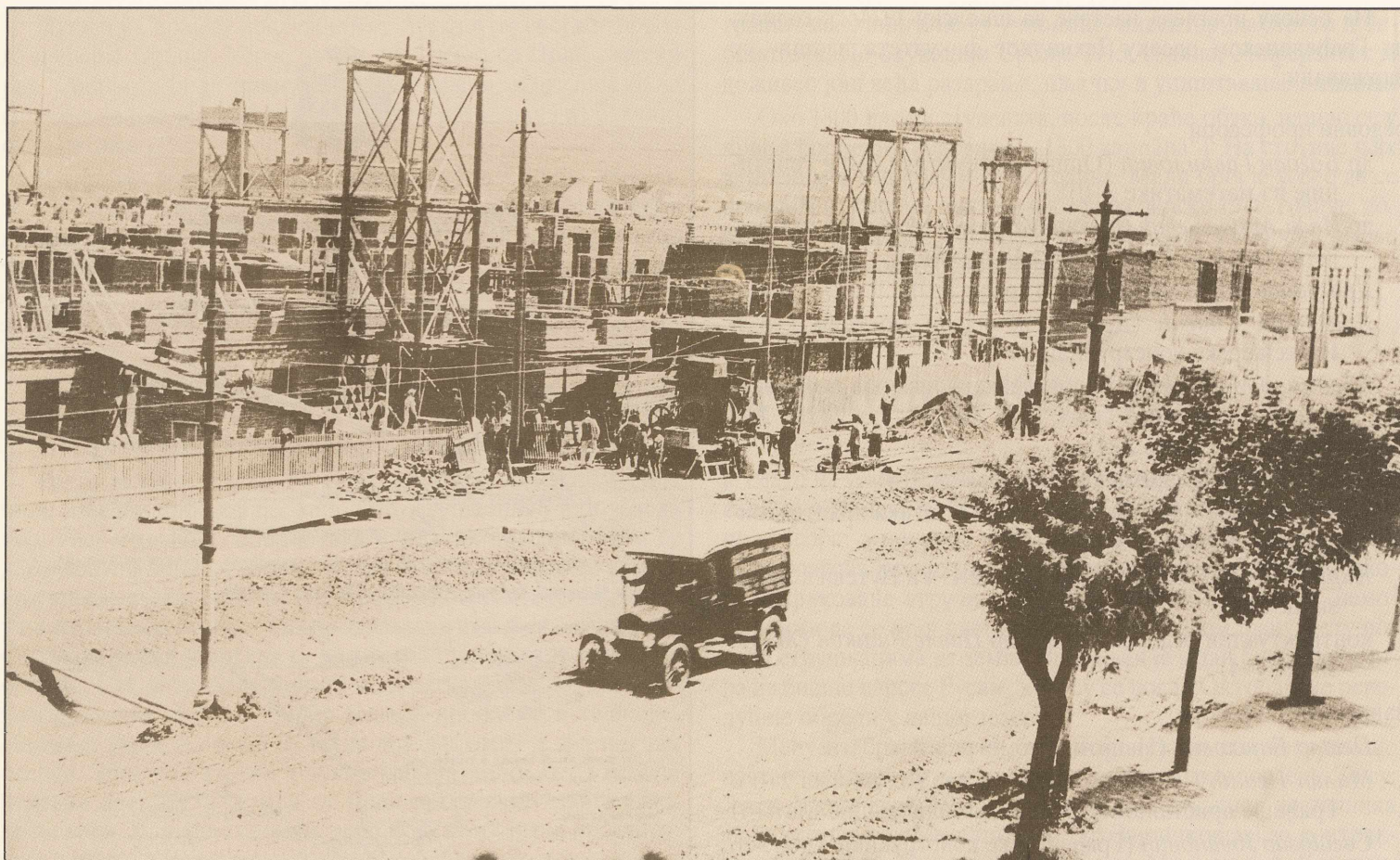
Изградња зграде Техничког факултета (1927)
