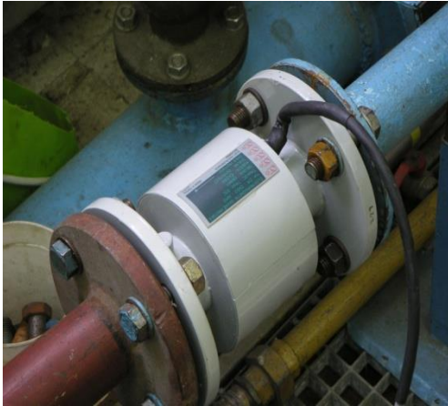
Сл.17. Електромагнетни давач протока Тип: EM-DN50 NP10
