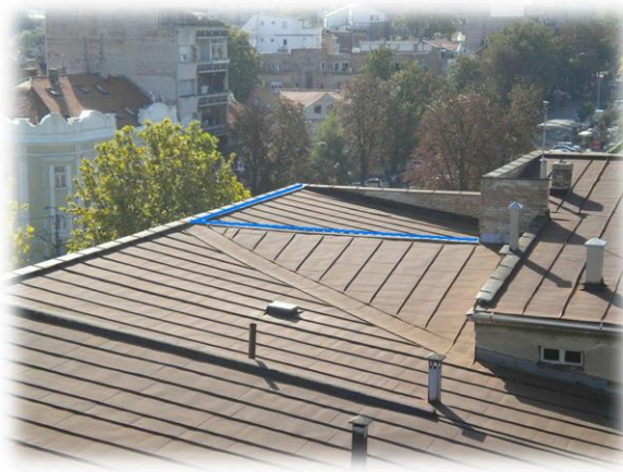
Слика 3. Део крова Института за хидротехнику површине 100 \text{ m}^2 који служи као репрезентативан узорак за анализу протока кишнице са кровова
