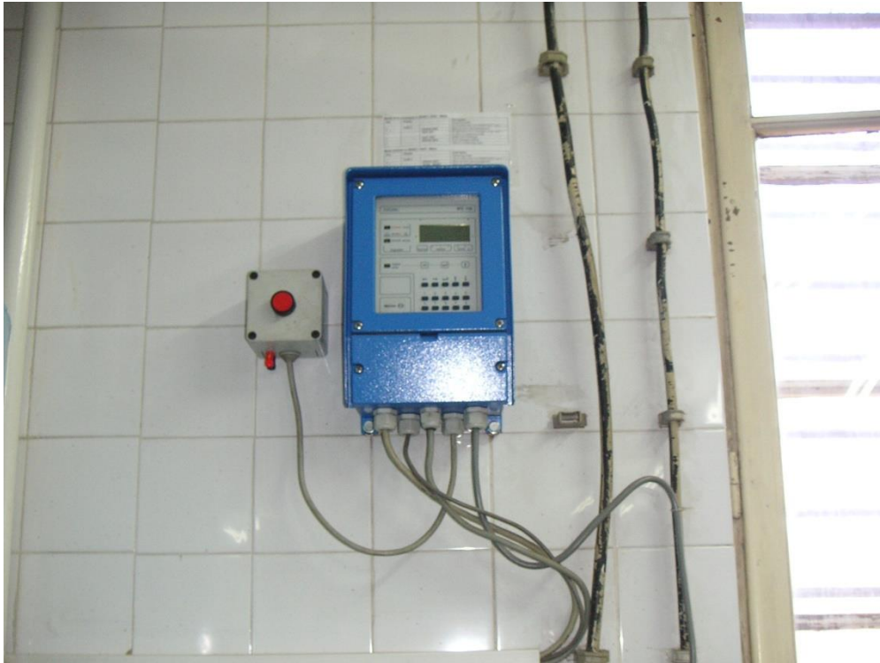
Slika 12: Uređaj za merenje protoka
