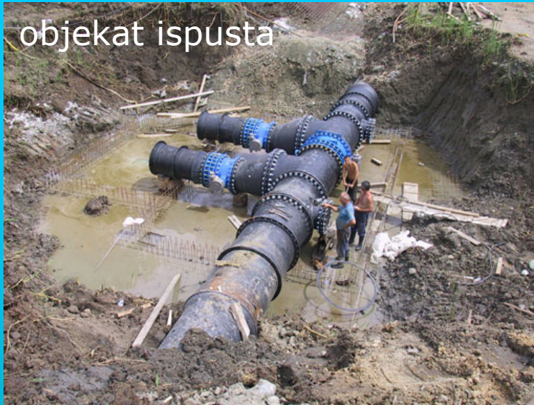
objekat na cevovodu (šaht zatvarača)
