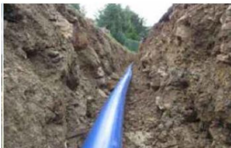
Slika 16. Instalacija HDPE_RC cevi u rov bez posteljice
