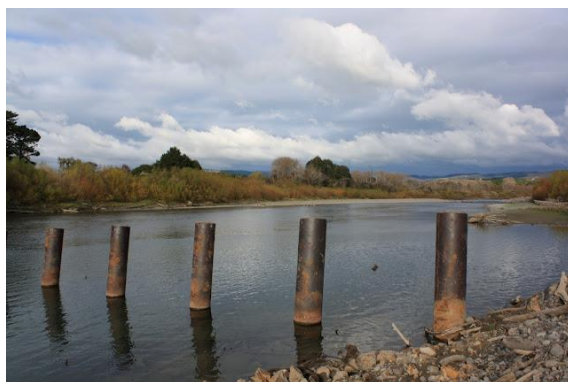
Slika 1. Tipičan usamljeni protočni naper od cevastih šipova [10].
