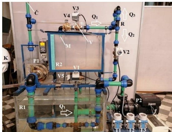
Slika 1. Izgled pokazno-obrazovne instalacije.
